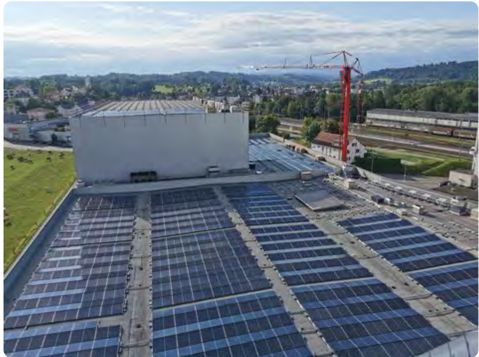
Photovoltaik-Anlage während der Endphase der Installation am Standort Sulgen
